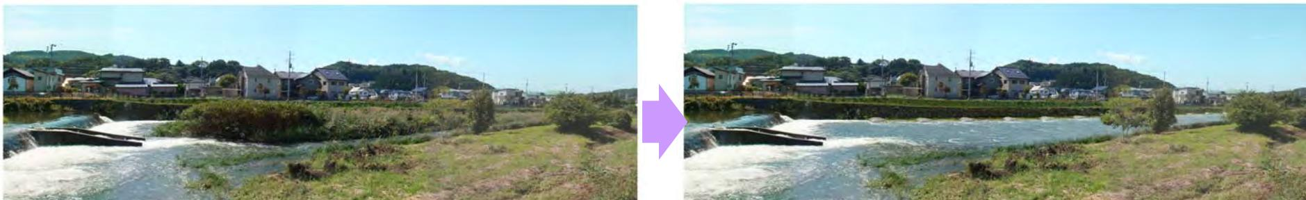
中州を撤去し、水制を設置したイメージ
